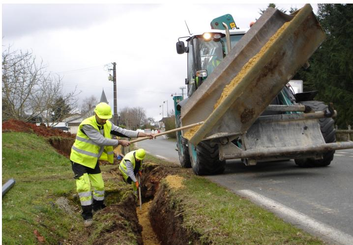
Une restructuration du réseau d'eau potable a été réalisée par la pose d'une nouvelle canalisation depuis le centre de soins situé dans le bourg jusqu'à l'intersection avec la route de Chalagnac. Au carrefour, le chantier est passé sous la route départementale en forage dirigé sans ouverture de tranchée.
